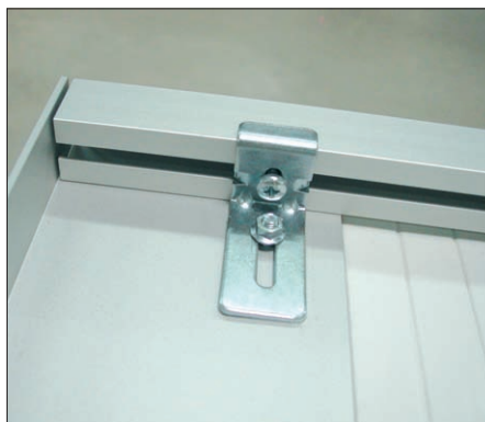
Détail liaison barre de battue haute/tapée cornière
